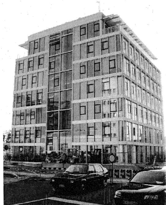
**Abbildung 1:** Niedrigenergie-Bürogebäude der Hafenbetriebe Frankfurt a.M. (Heizwärmebedarf = 35 kWh/m<sup>2</sup>a)
