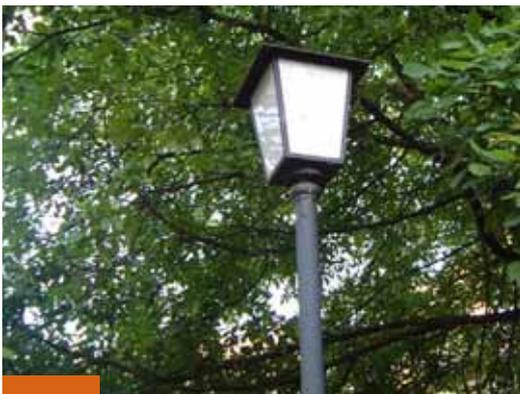
Kubische Mastaufsatzleuchte, beispielsweise im Bereich Marstall, Neckarmünz-Platz oder auf der Alten Brücke, Lichtpunkthöhe ca. 3,00m
