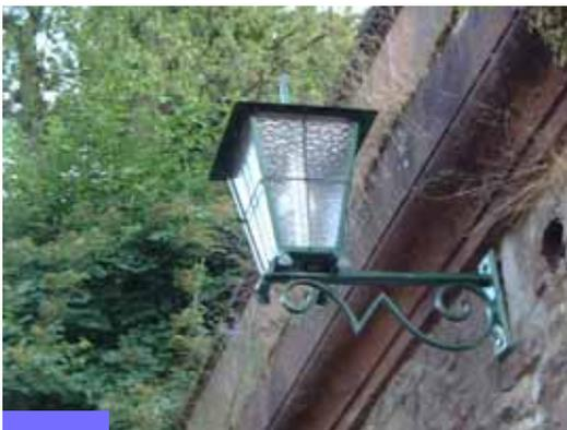
Wandauslegerleuchte Schinkel (hier: Jakobsgasse) Lichtpunkthöhe unterschiedlich, in der Regel zwischen 3,00m und 4,00m
