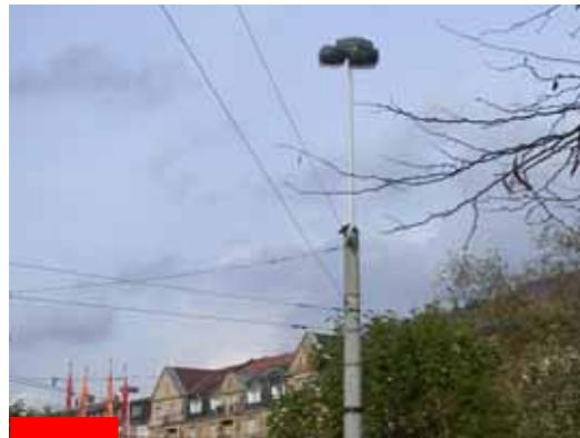
Mastaufsatzleuchten am Bismarckplatz Lichtpunkthöhe ca 8,00m
