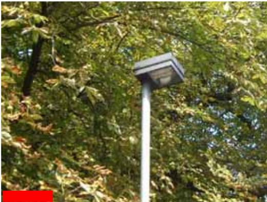
Technische Mastaufsatzleuchte in der Klingentorstrasse und am Oberen Faulen Pelz Lichtpunkthöhe ca. 4,00m
