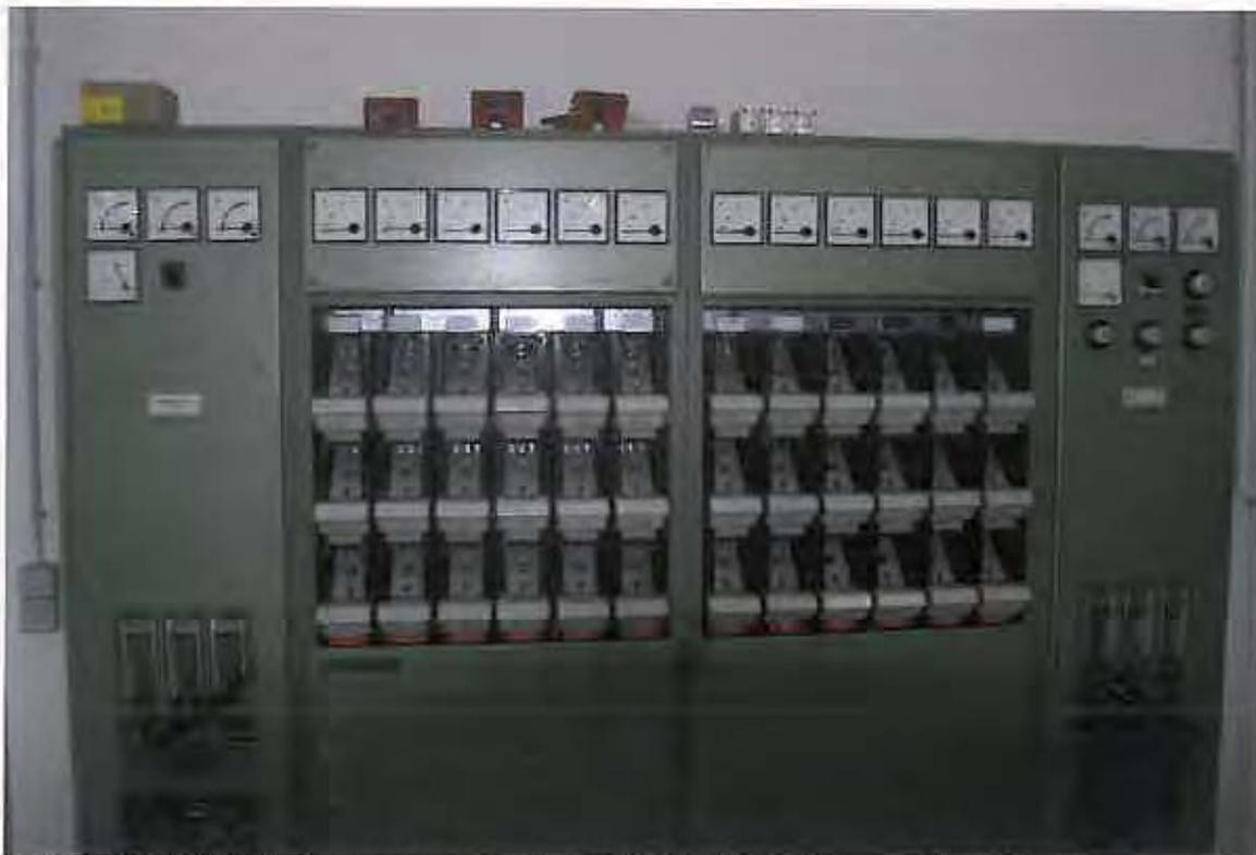
Abb. 8: 0,4 kV – Niederspannungsanlage mit Schaltfeld für zwei Transformatoren
