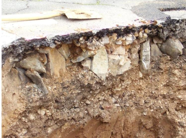
Abb. 3: „Altbauweise“; Störung der Packlage durch Aufgrabung
