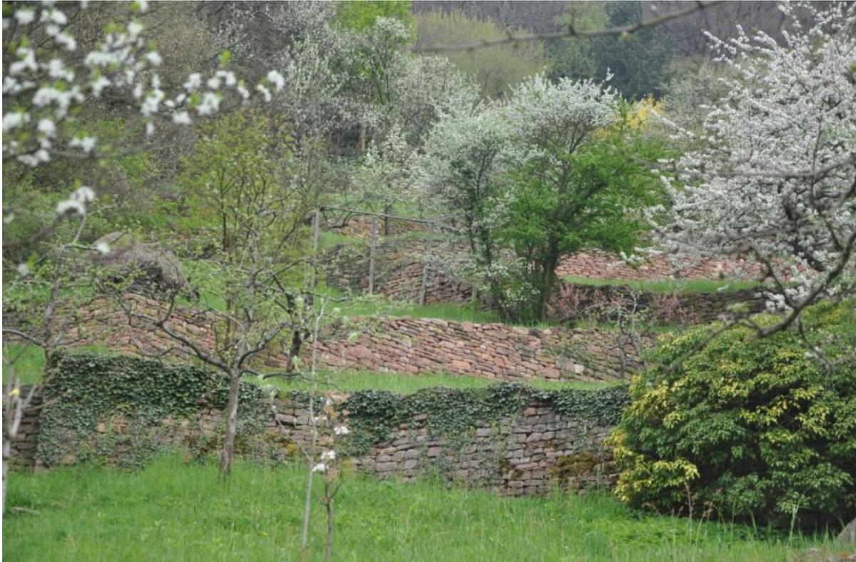
Abb. 19: Trockenmauern terrassieren den Hang; Foto: B.A./, 2013
