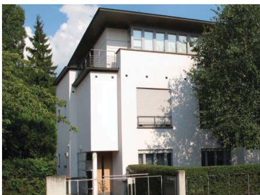
Abbildung 34 - quadratische Öffnungen ohne Fassung, bodentiefe Fensterformate
