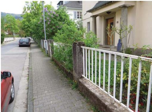
Abbildung 16 - schlichte vertikal betonte Einfriedung aus den 1920-er / 30-er Jahren mit Sockel und Pfeiler
