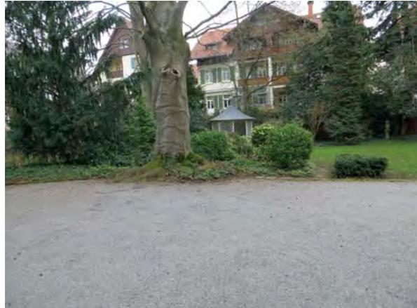
Abbildung 2-1: Beispiel für wasserdurchlässigen Belag (wassergebundene Wegedecke Roonstraße 10)
