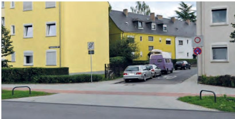
Abbildung 24: Aufpflasterung im Einmündungsbereich in Trier<sup>77</sup>
