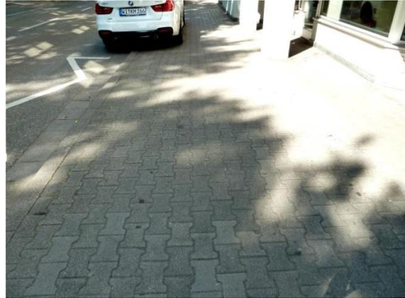
Bild 4: Doppel-T-Verbundsteinpflaster, längs gelegt
