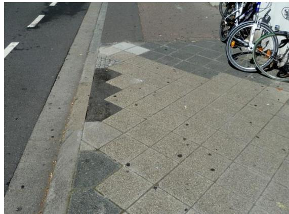
Bild 2: Gehwegplatten 30x30 cm, Im Hintergrund Doppel-T-Verbundsteinpflaster
