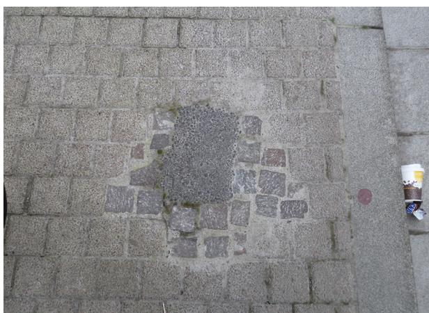
Schäden im Gehwegbelag, Ausbesserungen mit Asphalt
