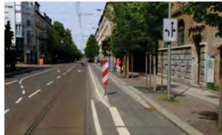
Beispiel für eine Haltestelle mit angehobener Radfahrbahn in Leipzig
