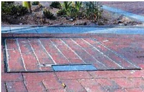
Kompaktes Schachtsystem für Steckdosenverteiler für CEE-Anschlüsse als Unterflur-Anschlussystem, überflutungssicher, schwenkbarer Faserverbunddeckel, bei geflutetem Schacht durch Tauchglockensystem auch im angeschlossenen Zustand problemlos ein- und ausfahrbar
