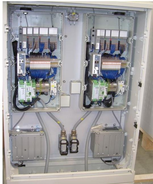
Steuerungsteil eingebaut in Standverteiler, Kunststoffgehäuse aus glasfaserverstärktem Polyester bestehend aus Ober- und Unterteil mit Sockel, Tür mit Verschluss, geeignet zum Einbau eines Halbprofilzylinders.
