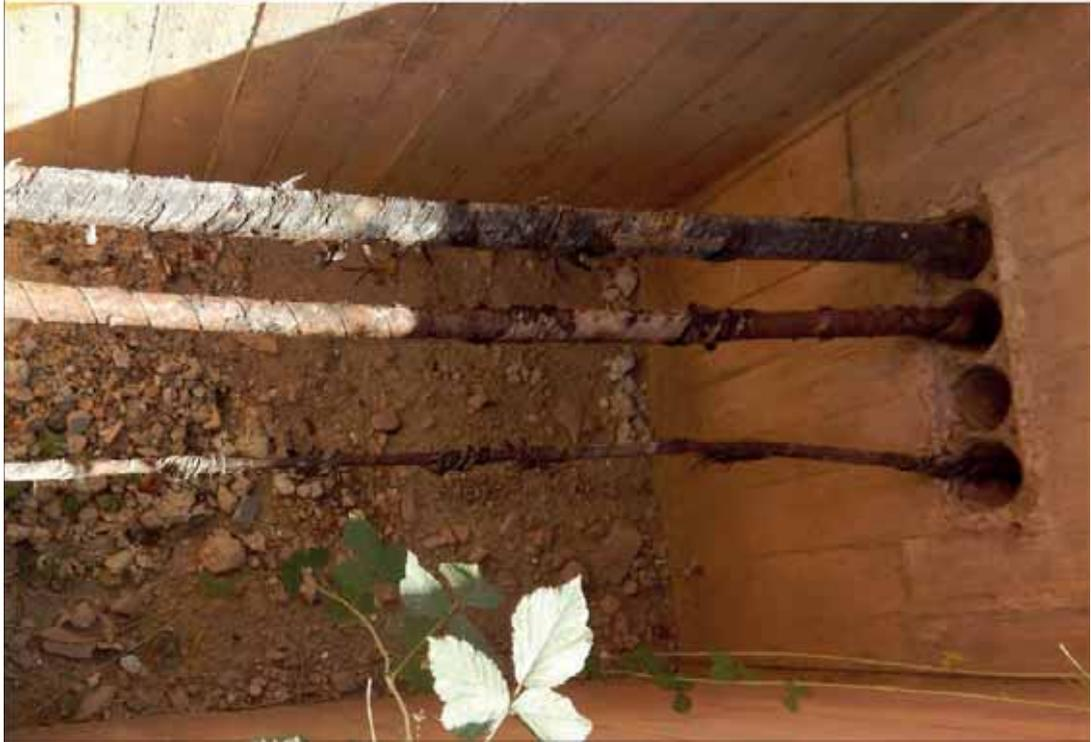
Abb. 3 Kabelschacht mit drei Altkabel (F4000; F4002 und ein Stromkabel).
