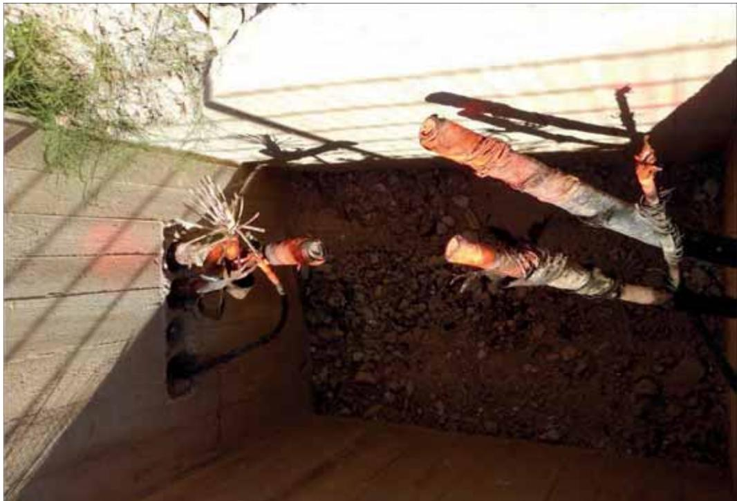
**Abb. 7** Kabelschacht mit den drei geschnittenen Altkabel
