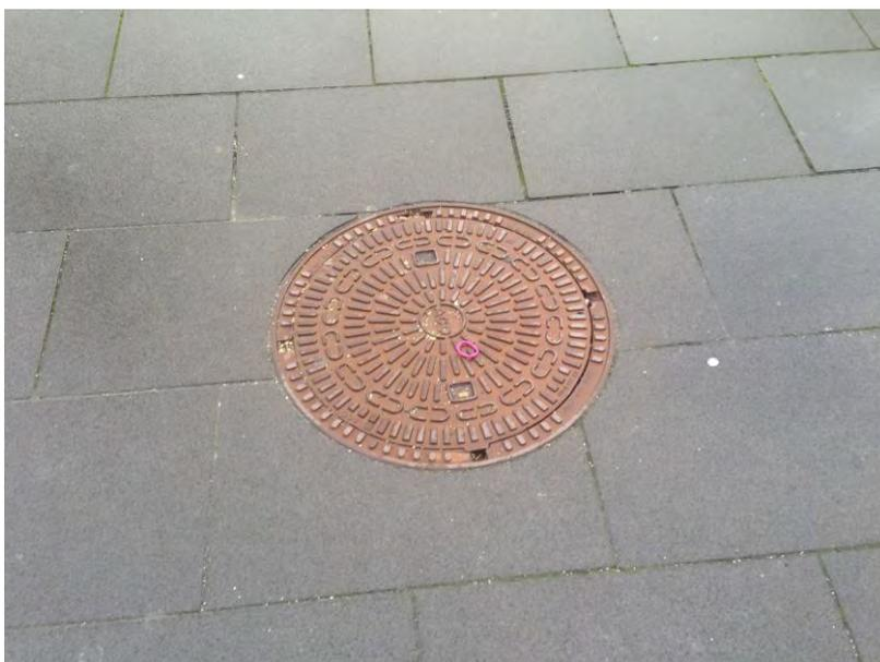
[4] Anschluss an runde Einbauten (Pflaster 40x60 cm)
