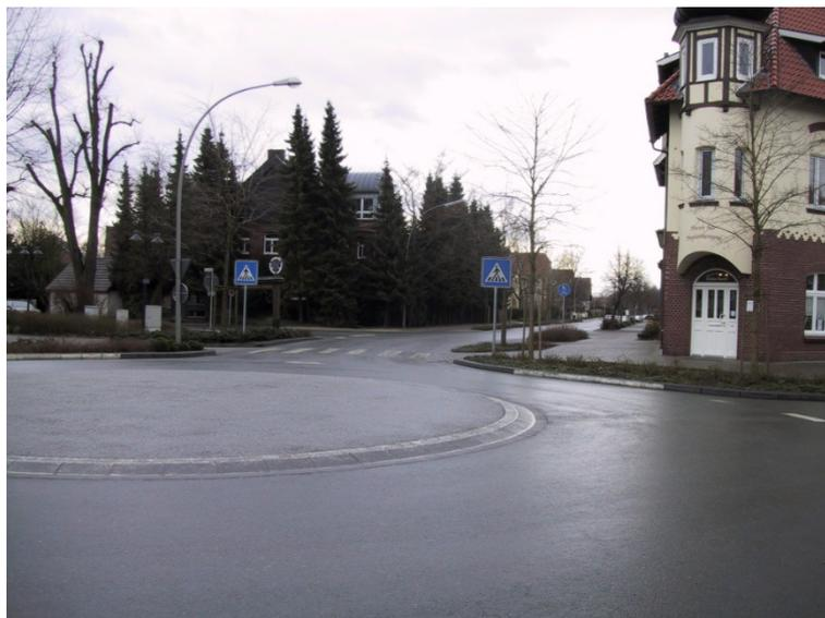
Abb. 7-7: Beispiel eines Minikreisverkehrs mit Einfassung der Kreisinsel durch Bordsteine (Rietberg)
