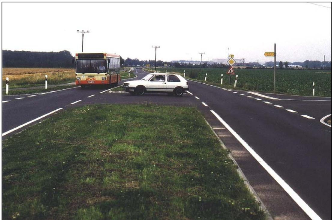
Abb. 7-4: Beispiel einer Mittelinsel in Höhe einer Kreuzung, die von Rad- und Kfz-Verkehr zum Kreuzen bzw. Abbiegen genutzt werden kann.
