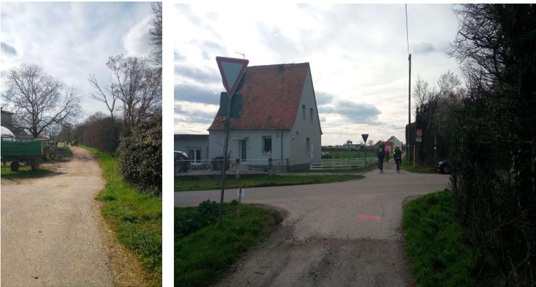
Ähnlich wie zuvor beschriebene Streckenabschnitte, ist dieser für eine gerade schnelle Verbindung unbedingt zu nutzen. Der Weg muss asphaltiert werden auf einer Breite von wenigstens 4 Meter. Bei Teilen mit zusätzlicher Nutzung durch Landwirtschaftlichen Fahrzeugen entsprechen mehr. Fußgänger sollten einen separaten Weg bekommen. Sie müssen den Radschnellweg intuitiv erkennen können!
