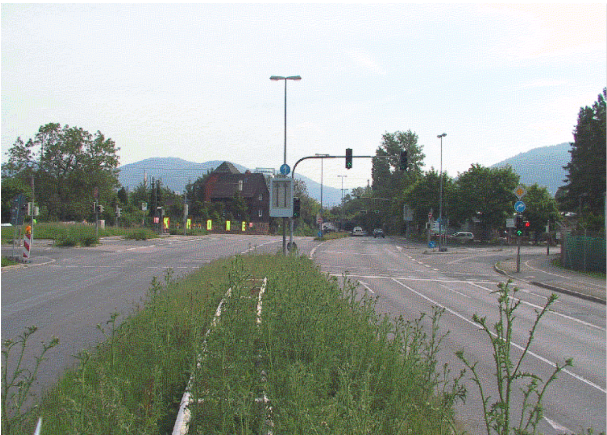
3.4 Blick über den Knoten Baumschulenweg Richtung stadteinwärts
