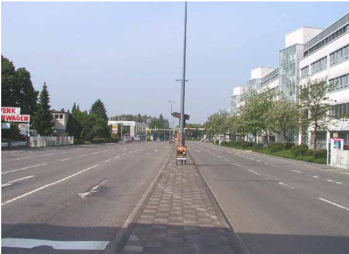
3.1 Blick entlang des ABB-Gebäudes Richtung stadtauswärts
