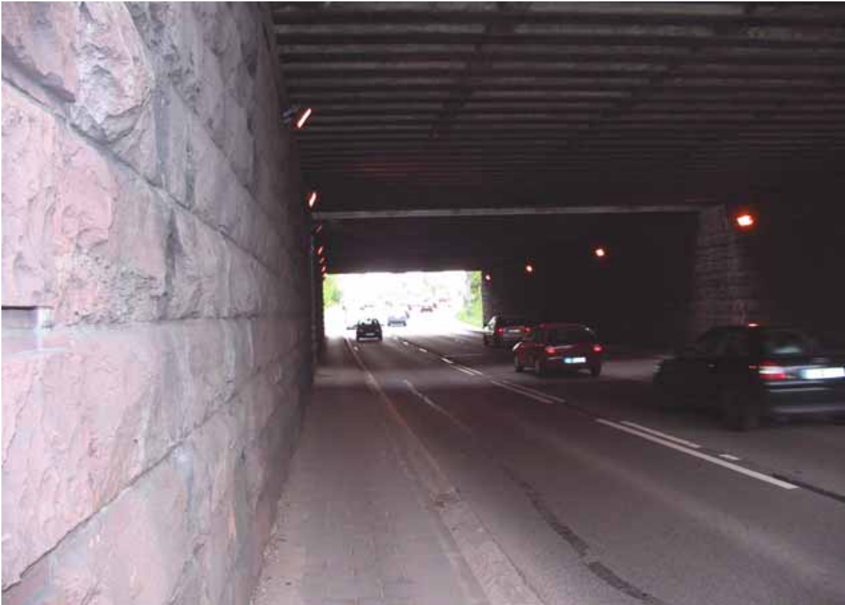
3.3 Unterführung (Blickrichtung Stadtauswärts)
