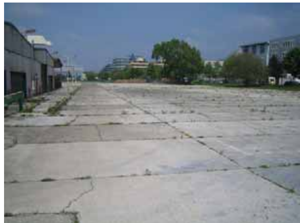
Abb. 2: Plangebiet, Blick nach Norden
