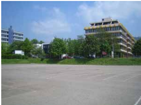
Abb. 5: Böschung, nordöstlicher Abschnitt
