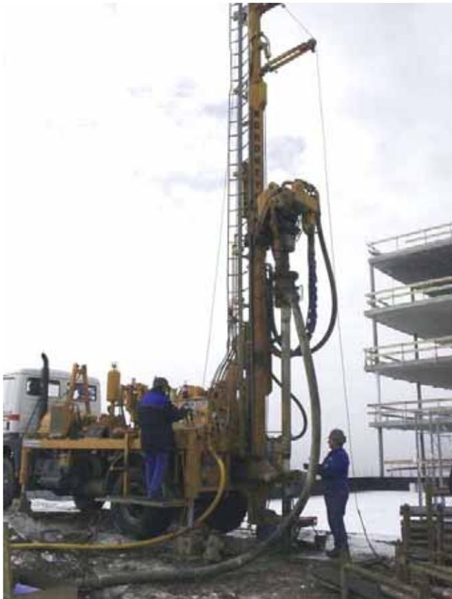
Abb. 33 Bohrung für eine Erdsonde (Bild ebök).
