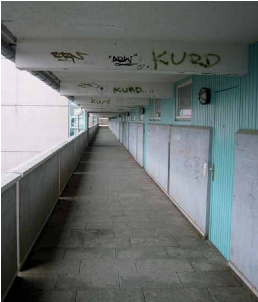
Abbildung 12: Emmertsgrundpassage 31a, Gang
