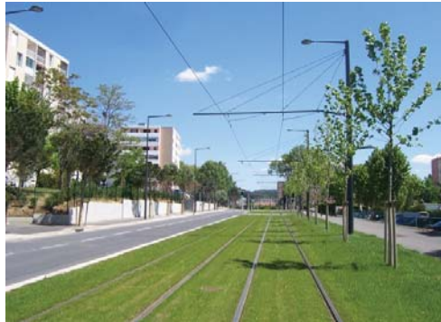
Bild 14: Mast in Baumreihe zwischen Trasse und Gehweg
