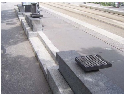
Bild 3: Beispiel rückwärtiger Haltestellenabgänge mit Stufen
