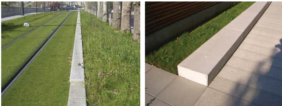
Bild 5: Abgrenzung des Bahnkörpers mit Rasendecke durch breites Steinband
