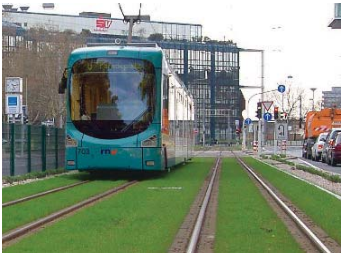
Bild 7: Gleisband mit schienenbündigem Rasengleis
