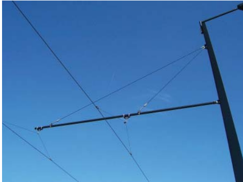
Bild 13: Nachgespannte Oberleitung ohne Tragseil
