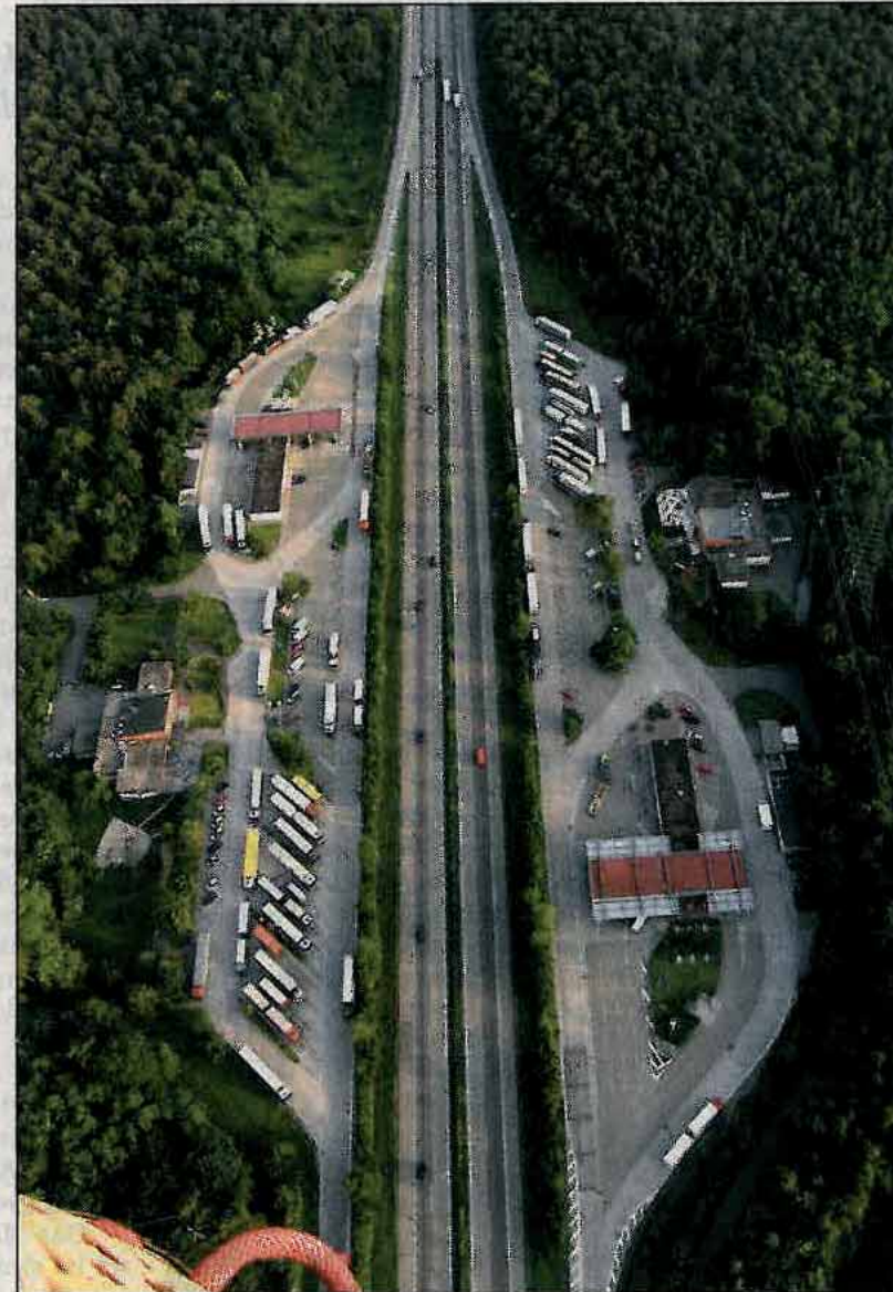
Die Rastanlage „Hardtwald“ liegt im Wald. Foto: www.heidelberg-ballon.de
