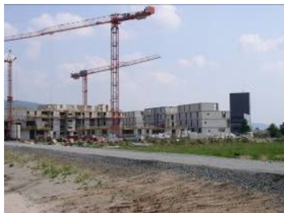
Blick vom „Langen Anger“ auf die Hochbaumaßnahme „Wohnquartier Schwetzingen Terrasse“ der GGH auf dem Baufeld W 6
