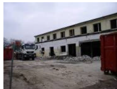
Abriss Gebäude Güteramtsstraße 15 / 17 November 2010
