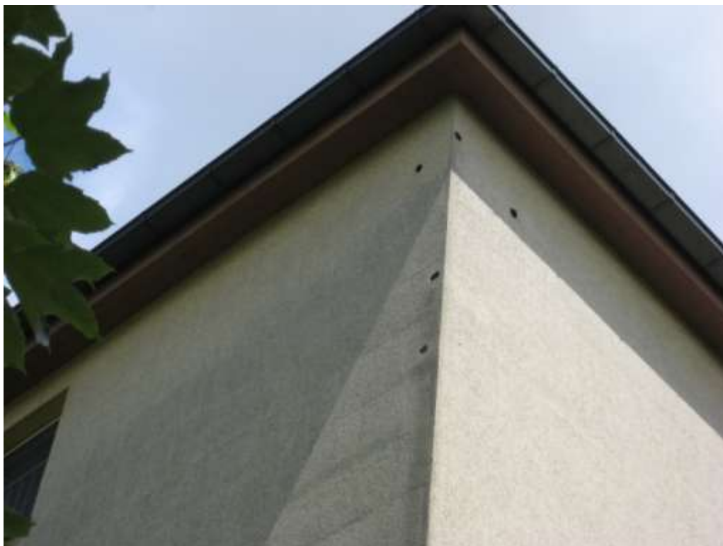
Foto 1: Potenzielle Spaltenquartiere in der Fassade
