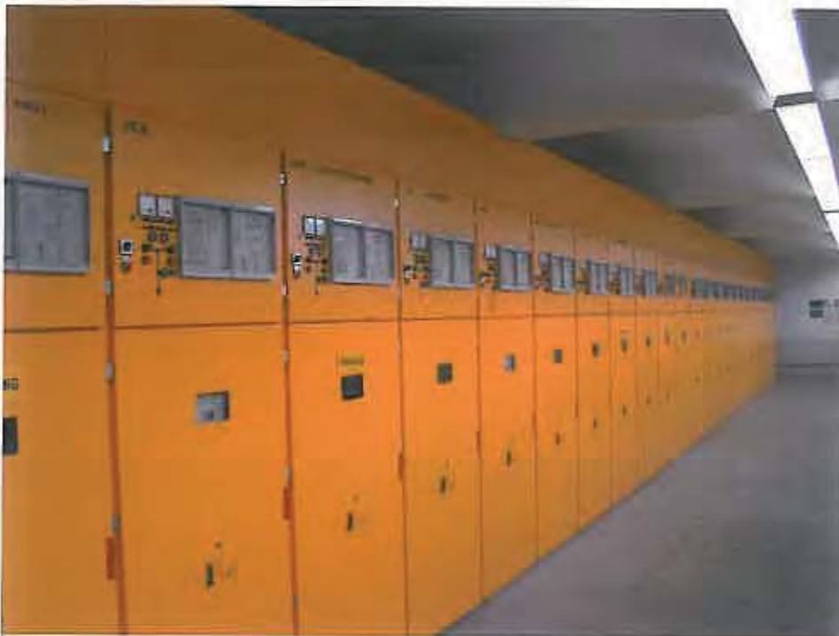
Abb. 6: 20 kV - Anlage
