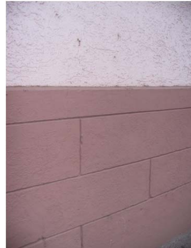
Abbildung 5: Gebäude mit Putzsockel nach Umbau.
