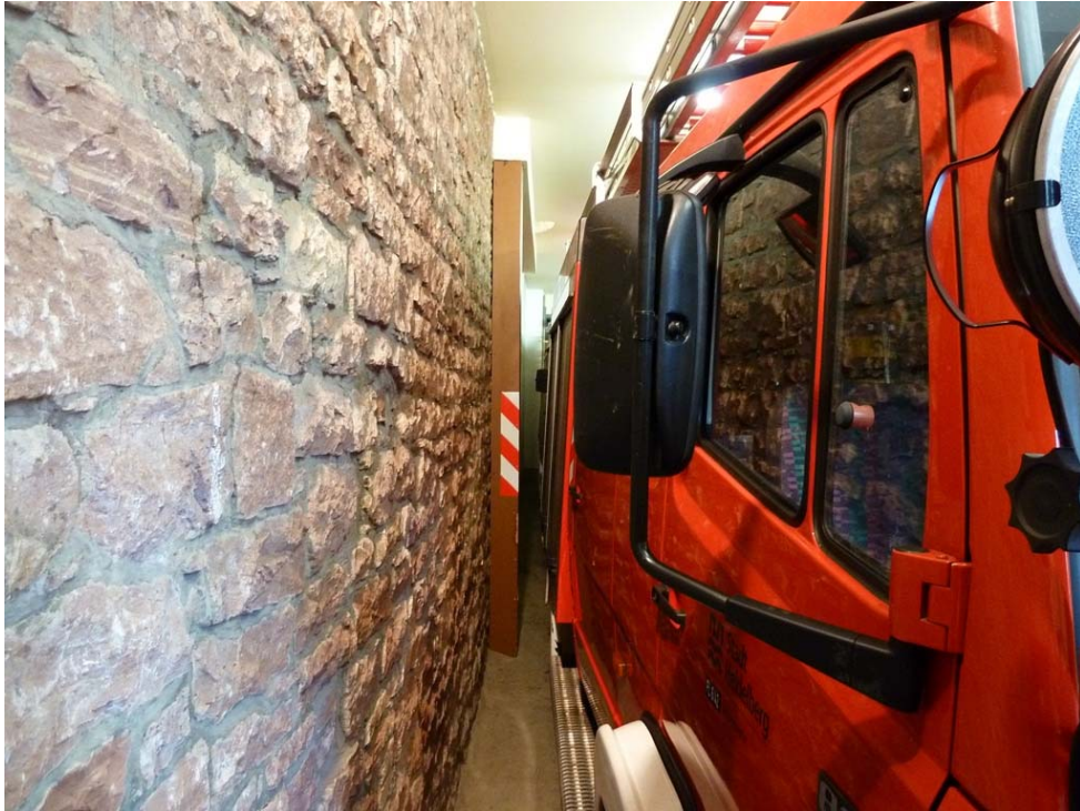
Bild 5: nicht eingehaltener Sicherheitsabstand von 0,5 Metern gegenüberliegende Wandseite
