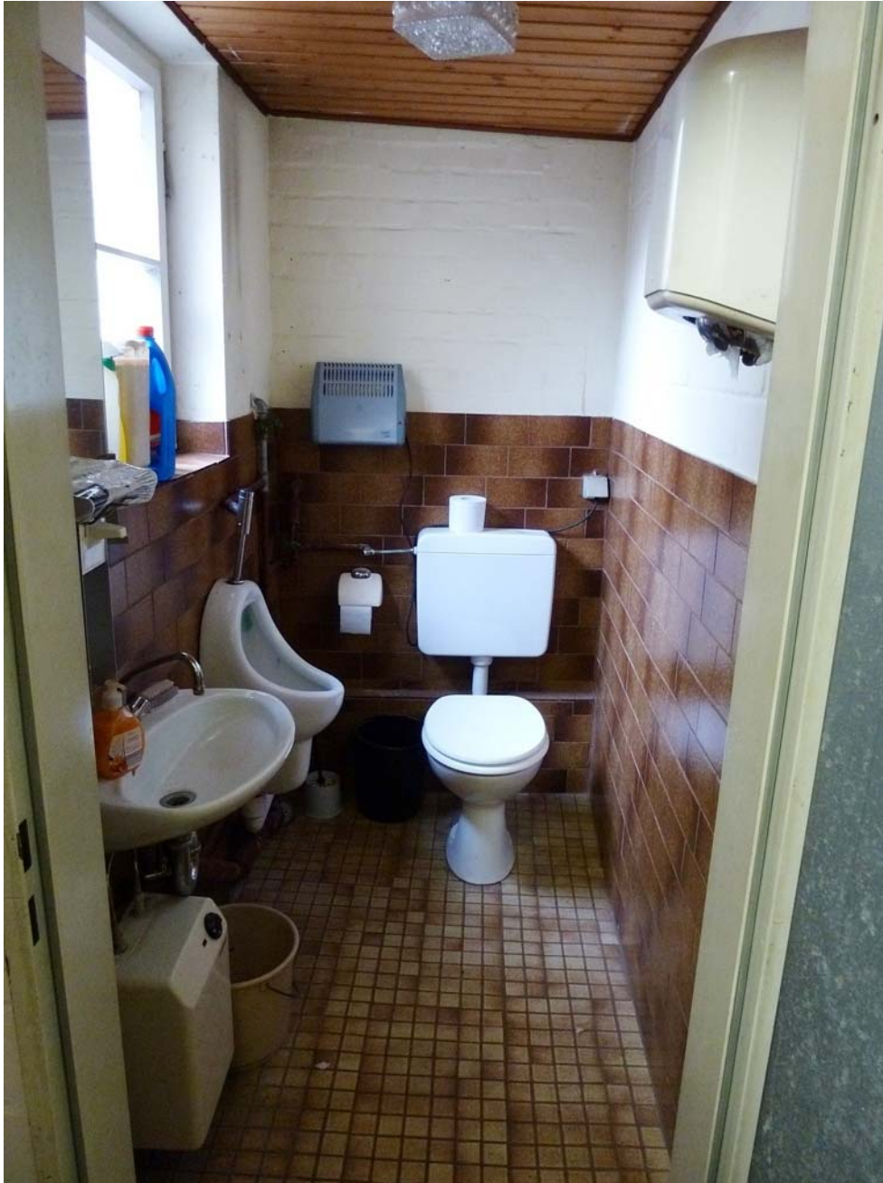
Bild 11 : Toilette mit Handwaschbecken
