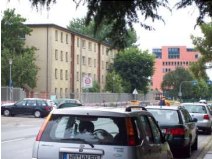
Abb. BImA Gelände an der Sickingenstraße
