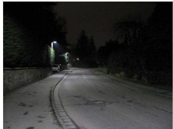
Steigerweg, LED Musterstrecke (Foto: Stadtwerke)
