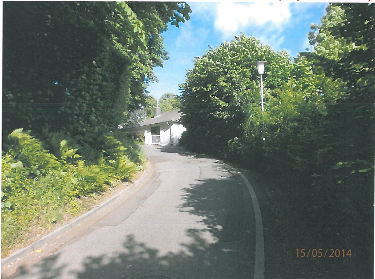
2.) In der Unteren Rombach, Kurvenbereich vor Nr.2 b Fahrbahn 3,6m / Seitenstreifen 0,6m
