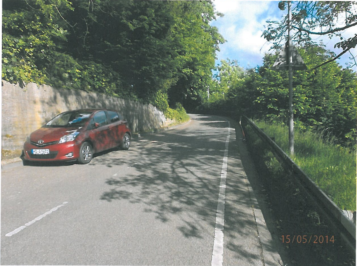
1.) In der Unteren Rombach, vor Wolfsbrunnensteige Fahrbahn 5m / Seitenstreifen 0,6m
