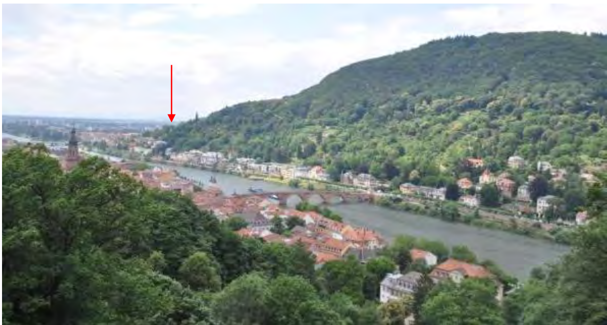
Abb. 10: Blick vom Schloss in Richtung NW ohne Zoom; der Pfeil markiert die Lage des Grundstücks Foto: B.A./, 2012
