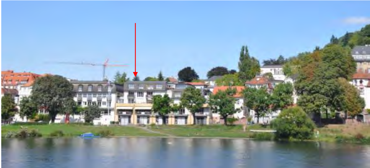
Abb. 6: Blick vom gegenüberliegenden Neckarufers (S nach N), Der Pfeil markiert die Lage des Grundstücks. Foto: B.A./, 2012
