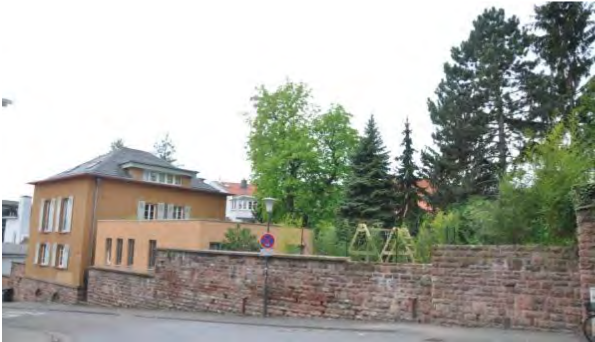
Abb. 2: Blick auf Gebäude und Gartenmauer von NO Richtung SW
