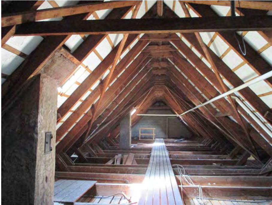
Foto 4: Blick in einen der Dachstühle
