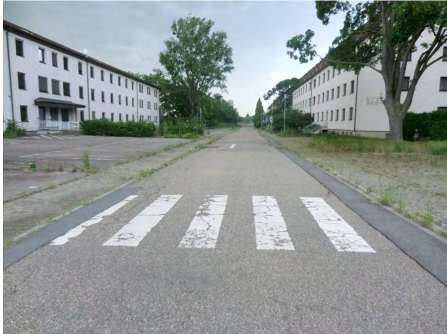
Abbildung 3 Straßenzug mit mehr- geschossigen Wohnge- bäuden im Mark-Twain- Village Nord.
