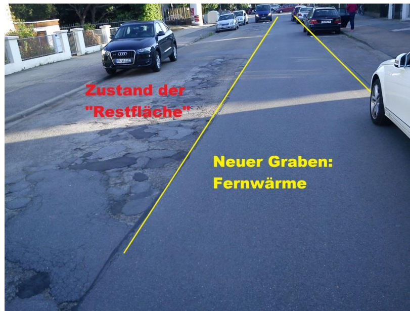
Abbildung 4: Beispiel. Wielandtstraße - Leitungsbaumaßnahme ohne Restflächen
