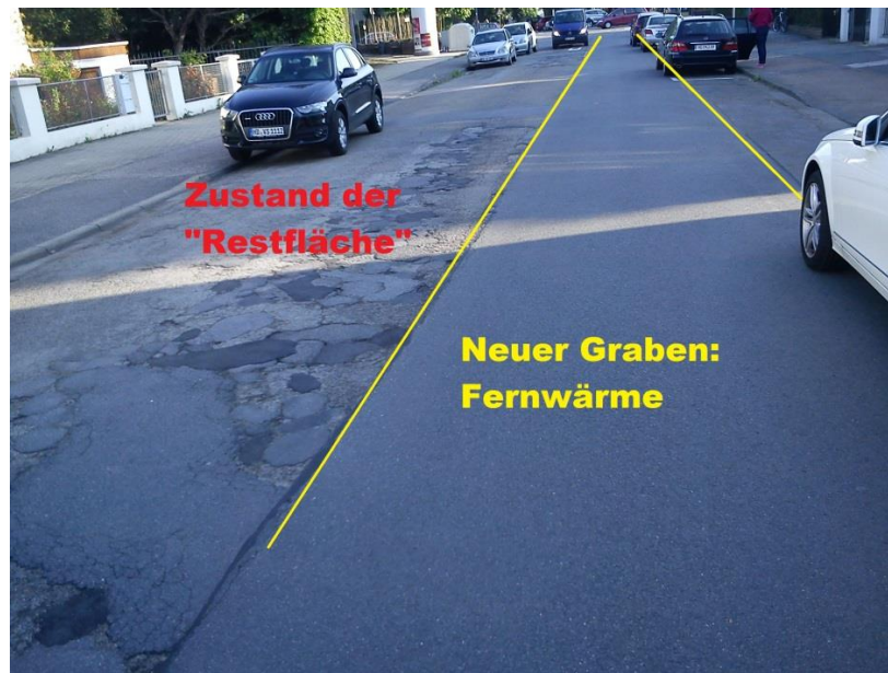
Abbildung 4: Beispiel. Wielandtstraße - Leitungsbaumaßnahme ohne Restflächen
