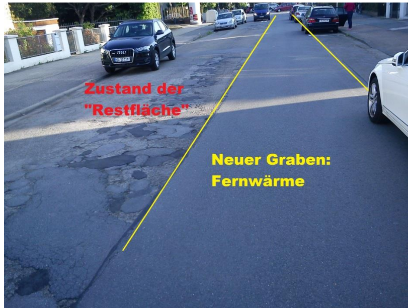
Abbildung 4: Beispiel. Wielandtstraße - Leitungsbaumaßnahme ohne Restflächen
