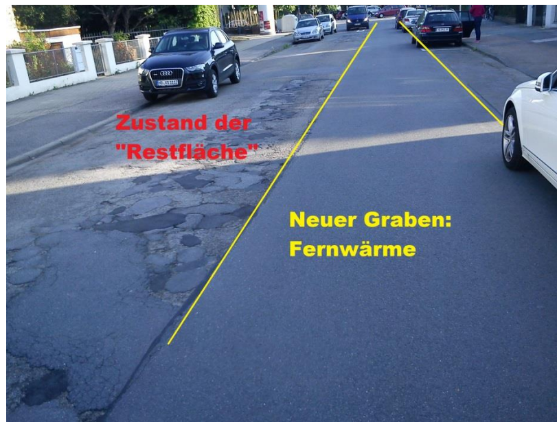
Abbildung 4: Beispiel. Wielandtstraße - Leitungsbaumaßnahme ohne Restflächen
