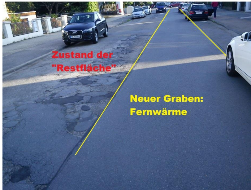
Abbildung 4: Beispiel. Wielandtstraße - Leitungsbaumaßnahme ohne Restflächen
