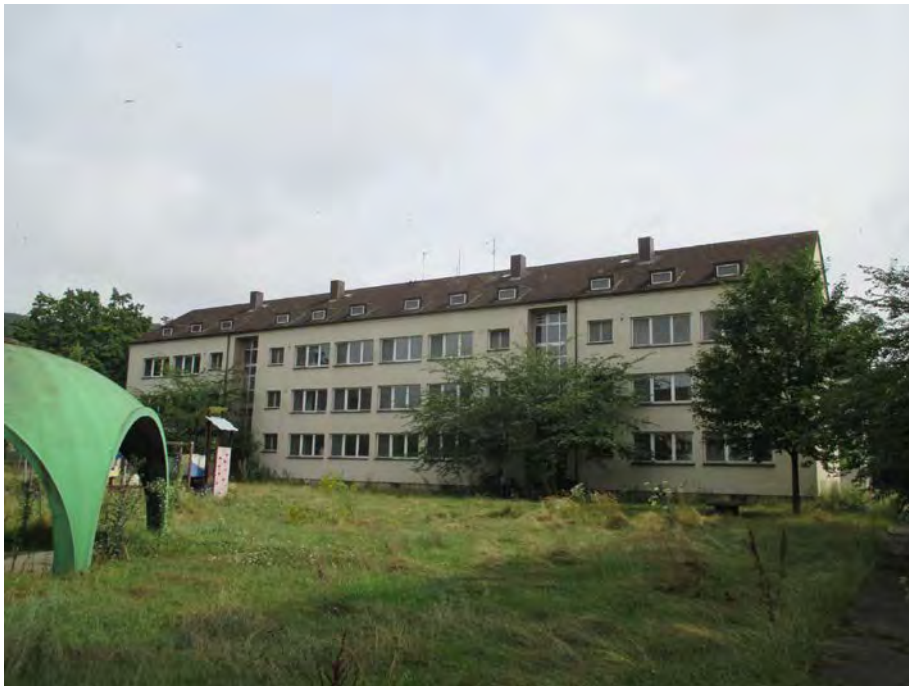
Foto 1: Gebäude 3703 (Ansicht von Norden)
