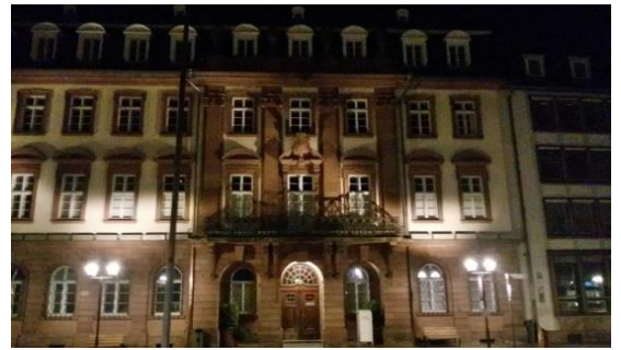
Foto rechts: Anstrahlung Rathaus, Hauptstraßenseite Quelle: Stadtwerke Heidelberg
