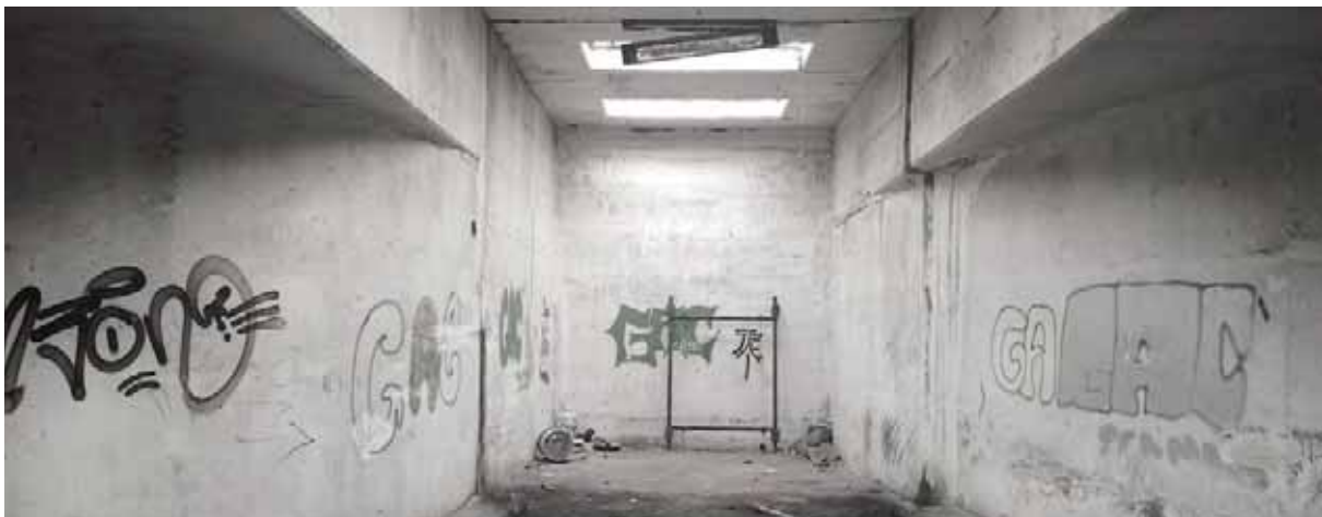
Übergangspunkt Rampenbauwerk zu Posttunnel
