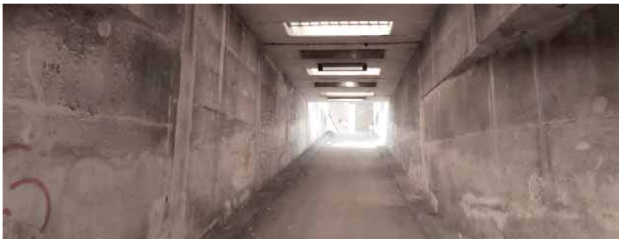
Posttunnel - Teilbereich 2 - Gleisaufgang
