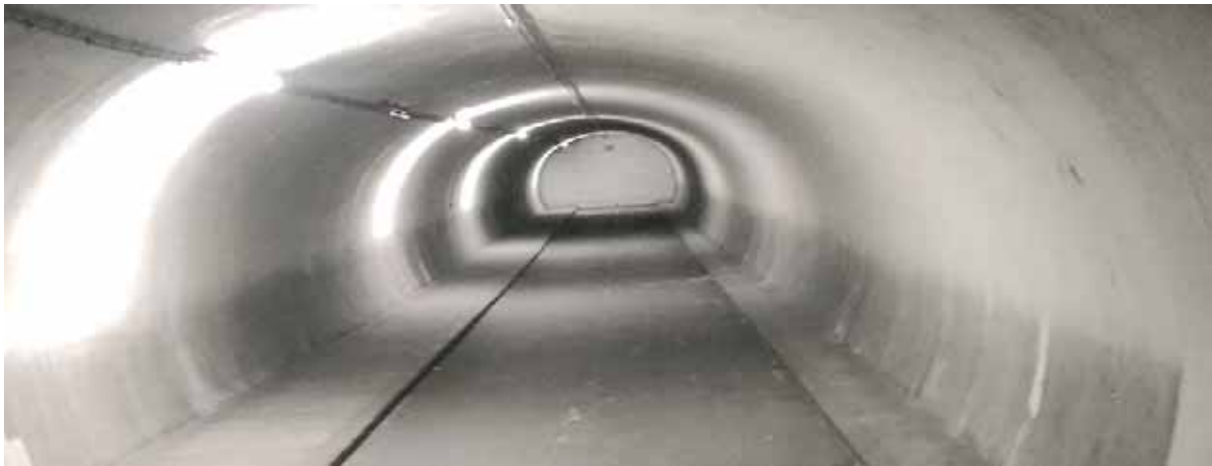
Foto – Blick Richtung Gleisanlage mit erkennbarer Steigung
