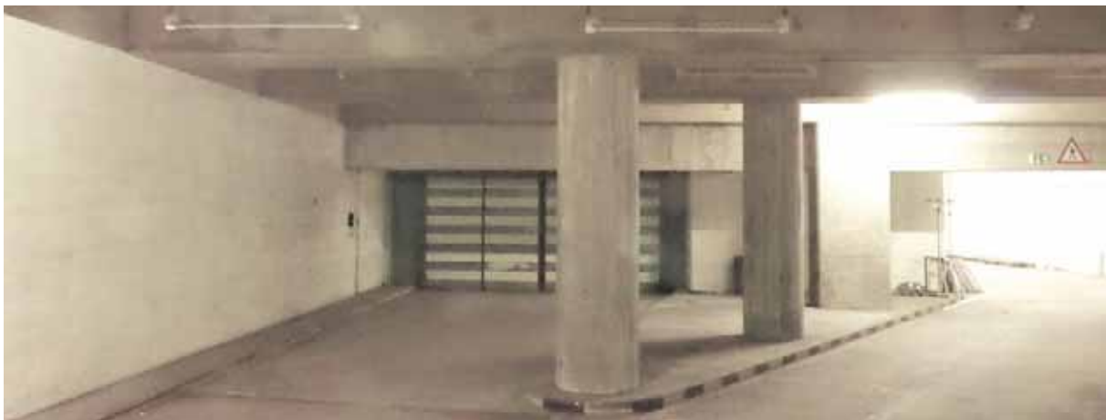
Foto – Übergang ehemaliger Posttunnel / Gebäude Belfortstraße 4
