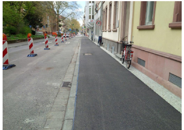
Mehrkosten für einen einheitlichen Oberflächenbelag. hier Asphalt mit einem Oberstreifen aus Naturstein wurde über PG Öffentlicher Raum finanziert
