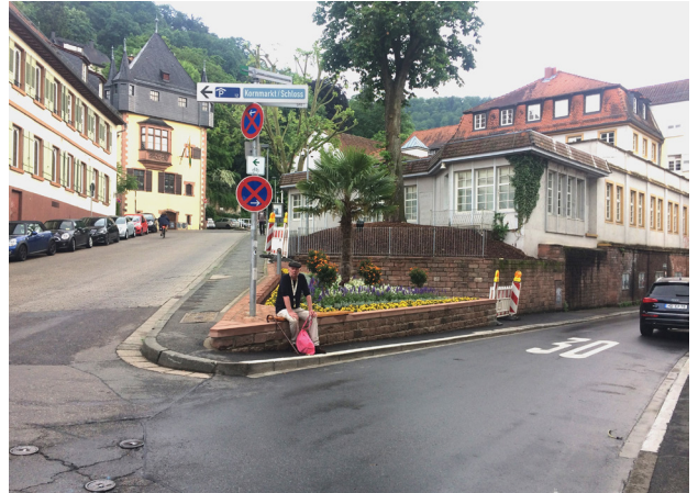
Sanierung der Sandsteinmauer und des historischen Geländers, Sitzauflagen auf der Mauer sowie eine attraktive Wechselbepflanzung haben den Ort verbessert.
