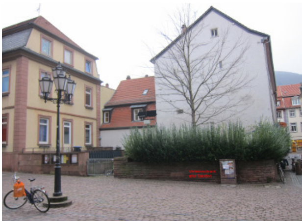
Altstadt, Richerd-Hauser-Platz 2016 Verteilerkasten auf öffentlicher Fläche im Bereich der Baumaßnahme "Haus der Begegnung" der Katholi- schen Kirchschaftnei.
