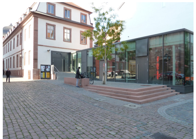
Kirche und Stadt Heidelberg teilten sich die Kosten für die Verlegung des Verteilerkastens um eine Platz- gestaltung zu ermöglichen.
