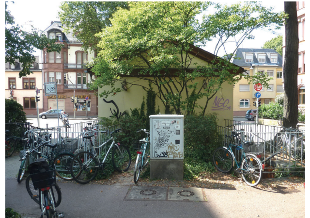
Rückseite des Kiosk, von der Grünanlage aus gesehen, mit den beiden mit Metallgeländern eingefassten Treppenabgängen ins UG
