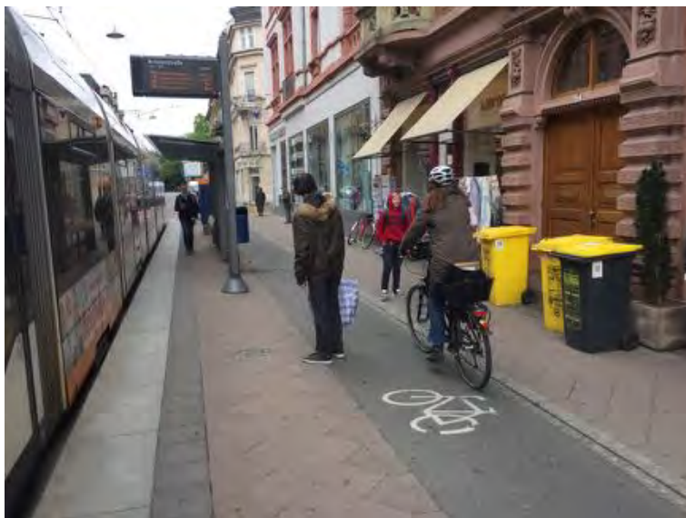
Abb. 93: Die Haltestelle Brückenstraße weist bei hoher Nutzungsdichte und Flächenknappheit eine Führung des Radverkehr hinter dem Bahnsteig auf. Dadurch entstehen dauerhaft Konflikte zwischen Rad- und Fußverkehr, sowie wartenden und ein-/aussteigenden Fahrgästen. Die Ausführung ist in diesem Gebietstyp daher nicht empfehlenswert.
