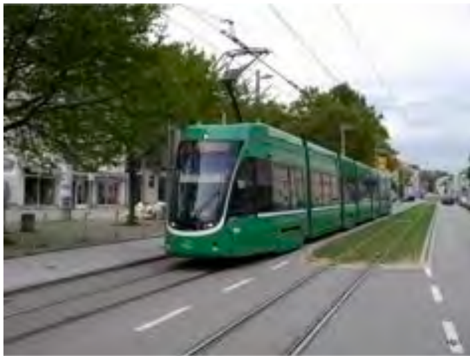
Abb. 111: Eingleisiger besonderer Bahnkörper mit Rasengleis und Hochbord.
