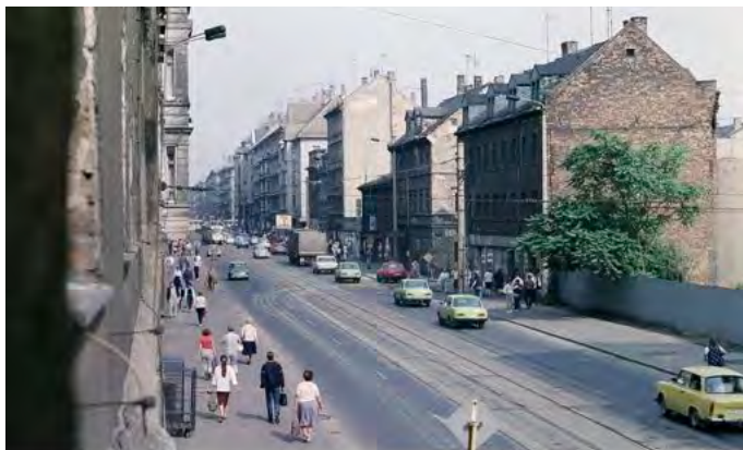
Abb. 115: Negativer Raumeindruck durch ungeordneten Verkehr und ausgeräumten Stadtraum – die Eisenbahnstraße in Leipzig vor ihrem Umbau (Quelle: Stadtplanungsamt)
