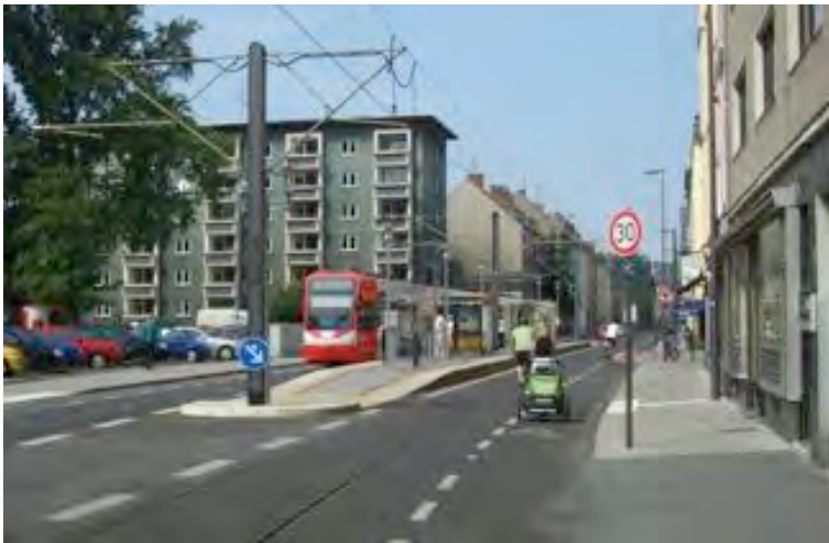
Abb. 88: Radverkehrsführung und Grundstückszufahrten sind bei Mittelinseln unproblematisch. Eine Herausforderung bei Flächenknappheit ist der hohe Platzbedarf für den Mittelbahnsteig. (Köln, Höniger Weg, Foto: Th. Dittmer)
