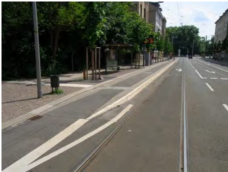
Abb. 78: Beispiel für eine Haltestelle mit angehobener Radfahrbahn. Die Radverkehrsführung ist gestalterisch als Teil der Fahrbahn ausgeführt (Leipzig Rödelstraße)
