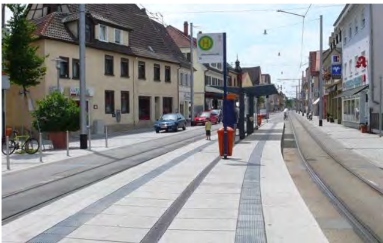
Abb. 89: Haltestelle Odenwaldstraße mit Mittelinsel in HD-Kirchheim mit sehr schmaler Ausbildung der Mittelinsel welche für Hauptstraßen mit starker Verkehrsbelastung nur bedingt zu empfehlen ist.
