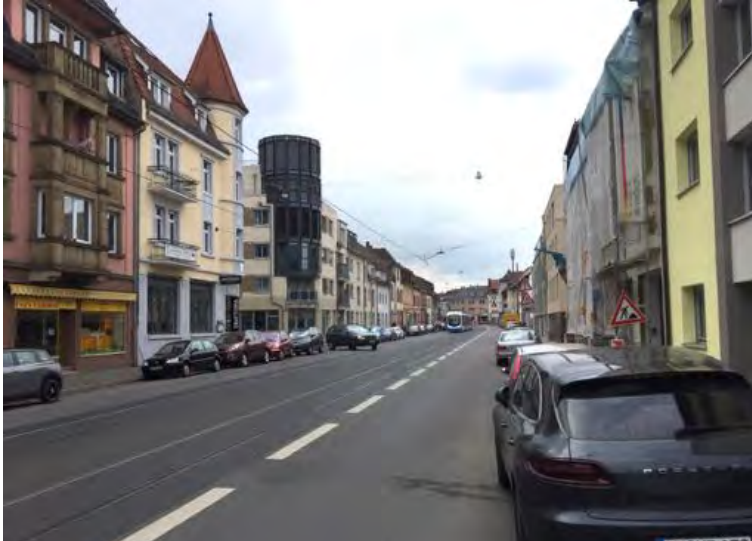
Abb. 21: Obwohl die Fahrbahn ausreichend breit ist und Begegnungsfälle erlaubt, wird auf dem Gehweg geparkt.
