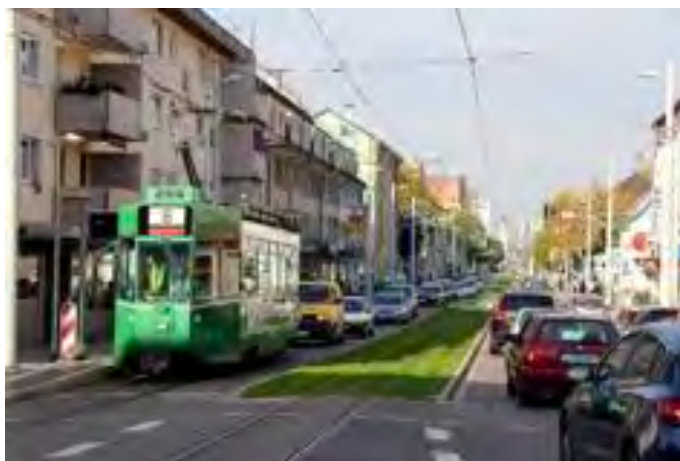
Abb. 112: Eingleisiger besonderer Bahnkörper mit Rasengleis ohne Angebot für den Radverkehr auf der Strecke und an Haltestellen
