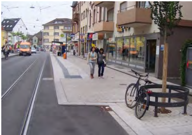
Abb. 97: Die Haltestellen im Zentrum von Rohrbach weisen keine Lösung für den Radverkehr auf. Die Radfahrer verkehren zwischen den Gleisen, zwischen Gleisen und Bahnsteigkante (Verkehrsraum < 1.0m) oder auf dem Bahnsteig. In allen Fällen kann es zu Konflikten und Gefährdungen kommen.
