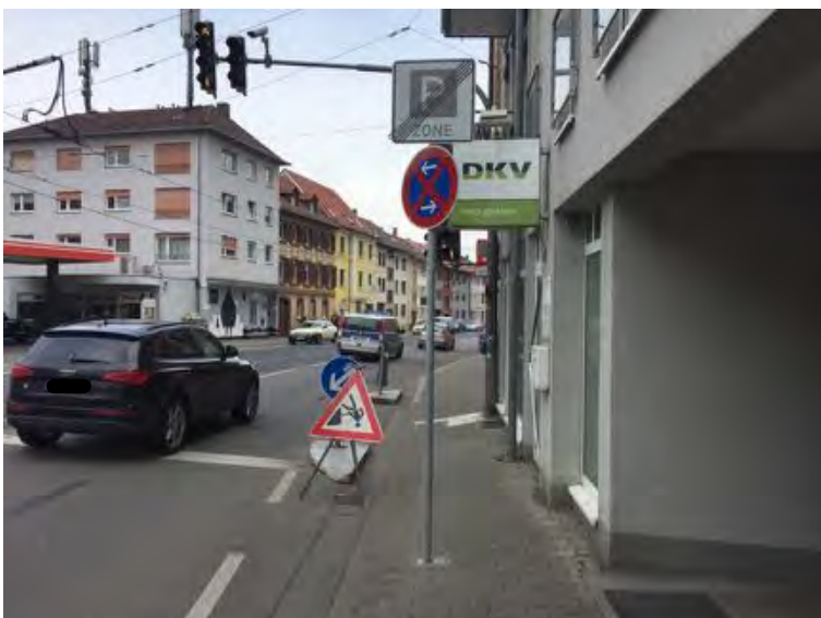
Abb. 17: Am Knoten Mühlingsstraße findet sich die einzige gesicherte Quermöglichkeit zwischen Hans-Thoma-Platz und Fritz-Frey-Straße. Der provisorische Charakter der Anlage wird deutlich. Aufstellflächen sind nicht in ausreichendem Maß vorhanden, denn zur Einordnung eines Linksabbiegers ist der Gehweg auf unter 2 m Breite reduziert.
