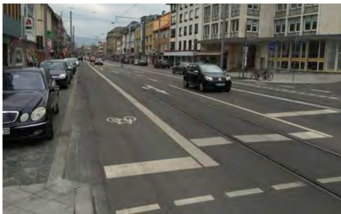
Abb. 59: Für die Beschleunigung der Straßenbahn bei straßenbündiger Führung ist insbesondere eine Vermeidung von Störungen durch Linksabbieger, Querungen und Parkvorgängen wesentlich (Beispiel Kassel Friedrich-Ebert-Straße).
