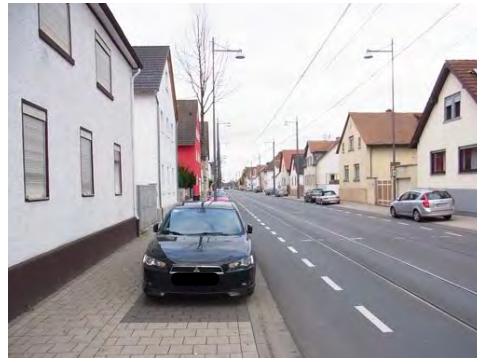
Abb. 127: Dominanz der Fahrbahnen und des Parkens mit nicht barrierefreien Gehwegen.
