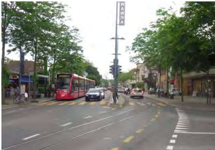
Abb. 101: Bern, Seftigenstraße Wabern – Linksabbieger zwischen den Gleisen, starker Linksabbieger, Tram hält am Fahrbahnrand
