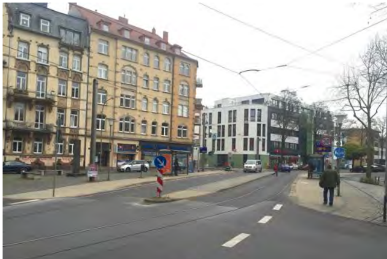
Abb. 82: Haltestelle mit linearer Mittelinsel als Querungshilfe mit Radverkehrsführung im Seitenraum (Kassel)
