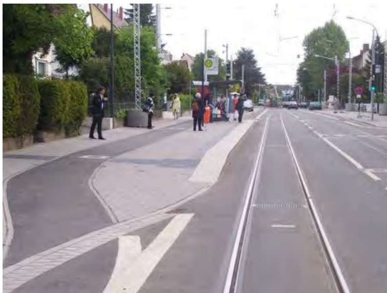
Abb. 95: Auch an den Haltestellen in der Rohrbacher Straße wird der Radverkehr durch den Seitenraum geführt. Dieser Ansatz ist in diesem Bereich bei geringer Nutzungsintensität vertretbar.
