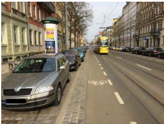
Abb. 91: Leipzig Könnerritzstraße - Bei schmalen Radverkehrsanlagen (hier 1,25 + 0,5 m) kann die Tram den Radverkehr ggfs. nicht überholen. Dadurch entsteht eine Verlangsamung für die Straßenbahn und eine ÖV-Förderung kann nicht akquiriert werden. Der Ansatz ist daher nicht wünschenswert.
