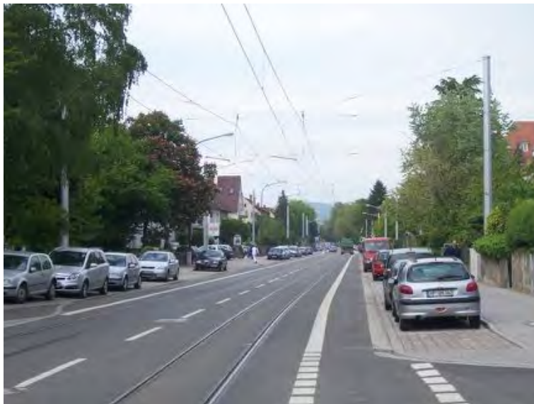
Abb. 94: Die Rohrbacher Straße weist eine sehr aufgelockerte Bebauung mit starken Grünbezügen auf. Die Ausbildung einer Allee ist hier nicht „erforderlich“. Durch die schmale Radverkehrsanlage, kommt es zu Behinderungen der Straßenbahn, da langsame Radler nicht überholt werden können.
