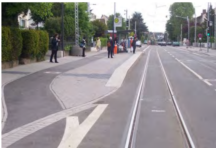
Abb. 76: Haltestelle mit Radverkehrsführung im Seitenraum mit geringen Nutzungsintensitäten in der Rohrbacher Straße.
