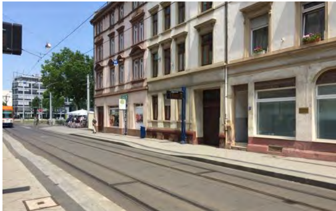
Abb. 84: Kaphaltestelle mit partieller Bordabsenkung für eine Grundstückszufahrt in Bahnsteigmitte. Für den Einsatz eher nicht zu empfehlen.
