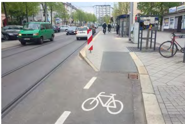
Abb. 79: Haltestelle mit angehobener Radverkehrsführung durch den Wartebereich. Hierbei ist für die Nutzer die Radverkehrsführung nicht erkennbar, wodurch sich Unklarheiten und Konfliktsituationen ergeben können (Kassel, Goethestr.)
