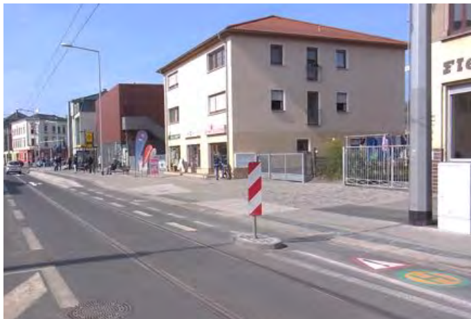
Abb. 85: Haltestelle mit angehobener Radfahrbahn ohne barrierefreien Einstieg im hinteren Bereich. Im Regelverkehr mit 30 m Fahrzeugen ist die volle Barrierefreiheit gegeben, bei Verkehren von 45 m Fahrzeugen ist der hintere Fahrzeugteil nur mit Stufe zu erreichen (Dresden).
