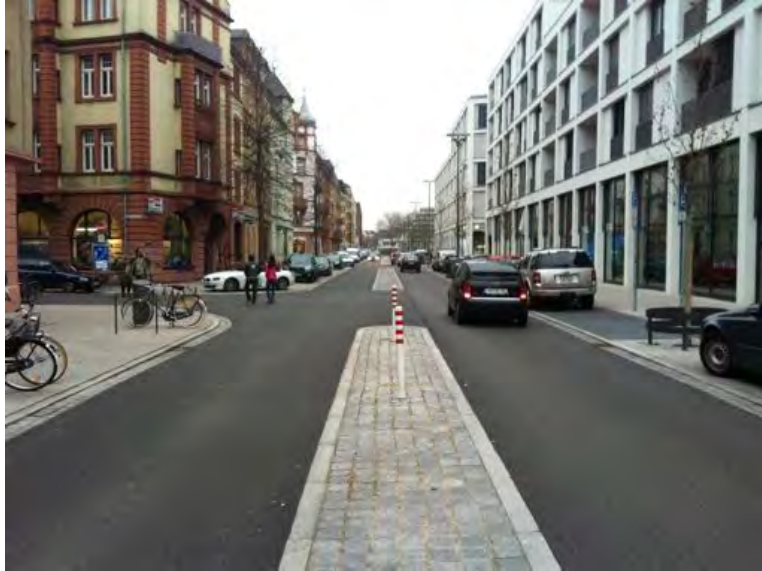
Abb. 98: Beispiel für einen schmalen Fahrbahnteiler als informelle Querungshilfe in der Bahnhofstraße (Heidelberg)
