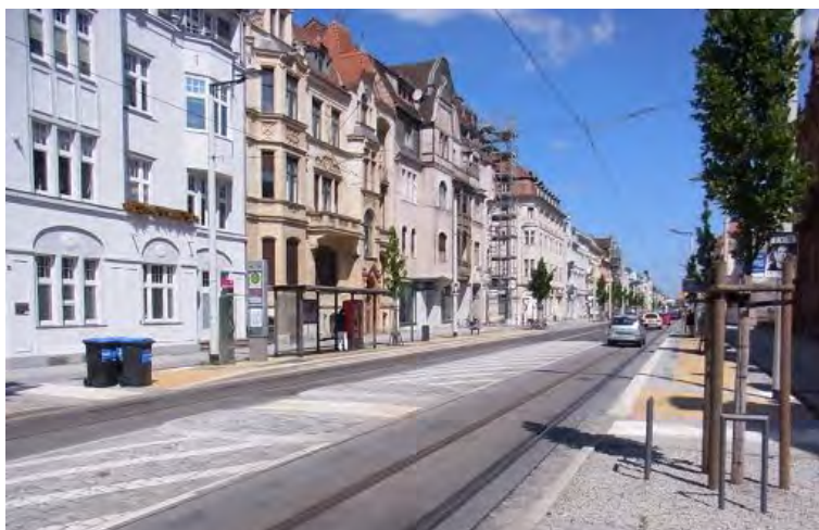
Abb. 83: Haltestelle mit linearer Mittelinsel als Querungshilfe beim Umbau der Bahnhofstraße in Cottbus.
