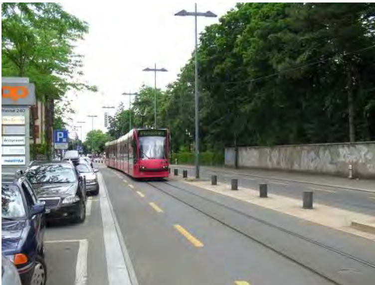
Abb. 99: Bern, Seftigenstraße Wabern – Tram als Pulkführer, Radverkehrsanlage, Mittelstreifen als Querungshilfe, Kurzzeitstellplätze im Seitenraum
