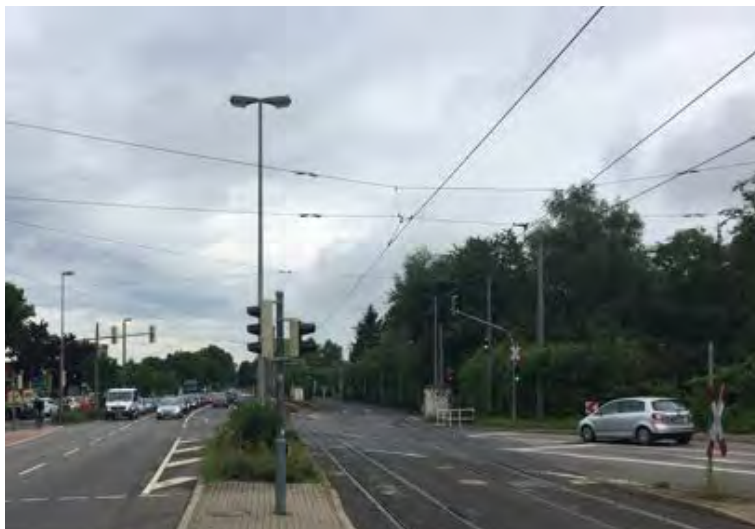
Abb. 29: Blick Richtung Abstell- und Wendeanlage und auf den Verschwenk der Gleise in die Seitenlage. Durch die zahlreichen kreuzenden Fahrten kommt es zu nicht unerheblichen Behinderungen für den stadtauswärtigen Kfz-Verkehr mit Rückstaubildung. Blick stadtauswärts.
