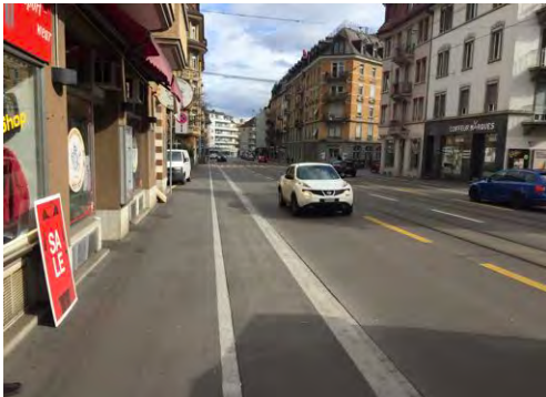
Abb. 126: Nachträgliche Anlage eines zu engen Radwegs zu Lasten der Fußwege.
