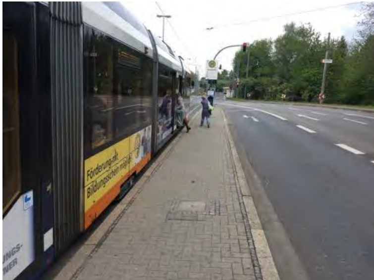
Abb. 28: Die bestehende Haltestelle Burgstraße am nördlichen Ende des Straßenzuges ist als Haltestelle mit Seitenbahnsteigen in Fahrbahnmitte ausgebildet („Inselhaltestelle“). Die Bahnsteige sind jedoch zu schmal und zu niedrig. Die Ausstattung mangelhaft. Ein barrierefreier Ausbau ist auch hier erforderlich. Blick stadtauswärts.
