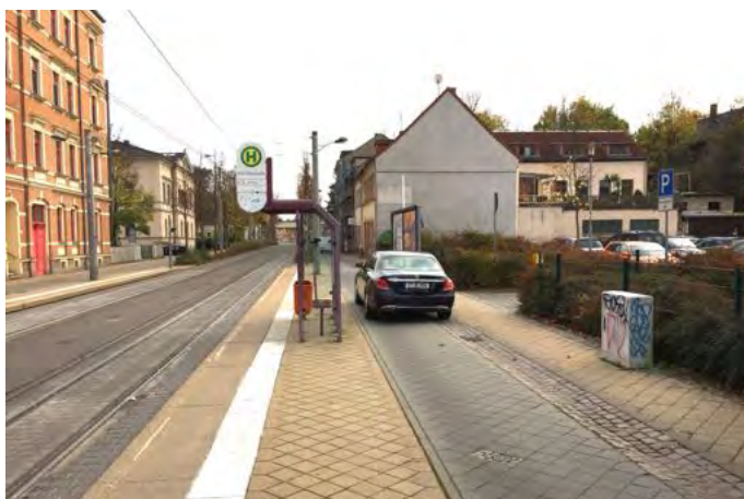
Abb. 86: Haltestelle mit „Multifunktionszone“ hinter dem Bahnsteig zur Erreichbarkeit von Grundstücken – verkehrsrechtlich eine Fußgängerzone frei für Anlieger und Radverkehr (Zwickau)
