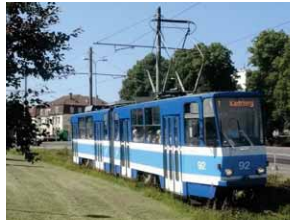
Beschleunigung des ÖPNV in Tallinn mit besonderem Bahnkörper für die Straßenbahn
